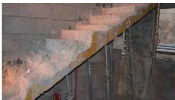
DEMOLICIÓN DE ESCALERAS
