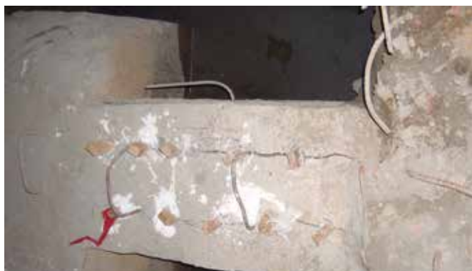
HORMIGÓN ARMADO EN VIGA
