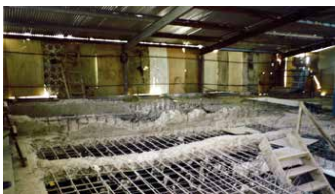
HORMIGÓN ARMADO EN SOLERA
