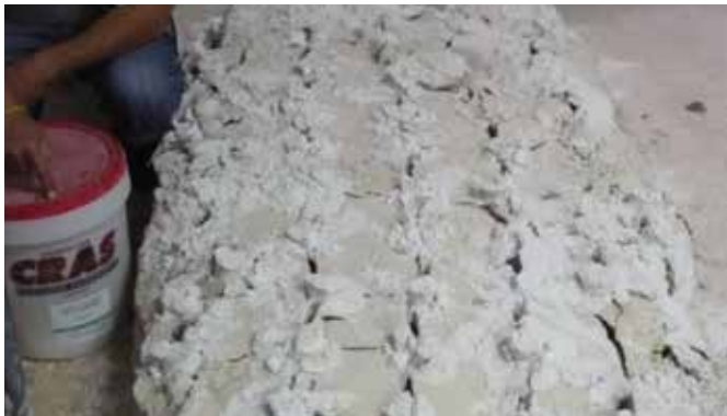
ROCA EN EL GARAGE
